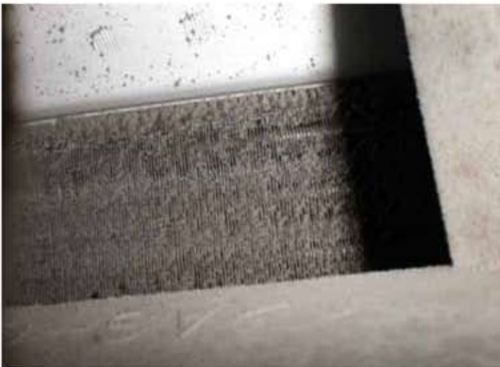
バックヤード 熱交換器 重位の埃の付着が見られます レベル5の汚れ進行中
