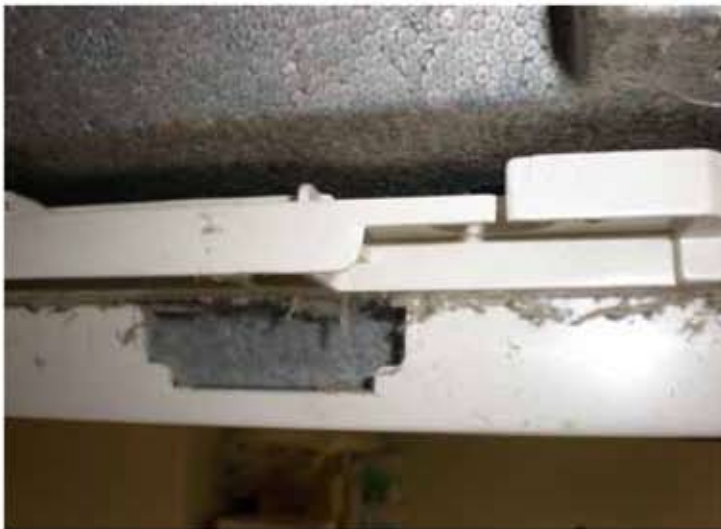
バックヤード カバー部分 重位の埃の付着が見られます レベル5の汚れ進行中
